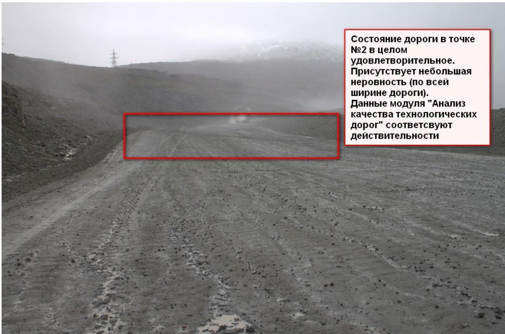
Состояние дороги в точке №2 в целом удовлетворительное. Присутствует небольшая неровность (по всей ширине дороги). Данные модуля "Анализ качества технологических дорог" соответствуют действительности
