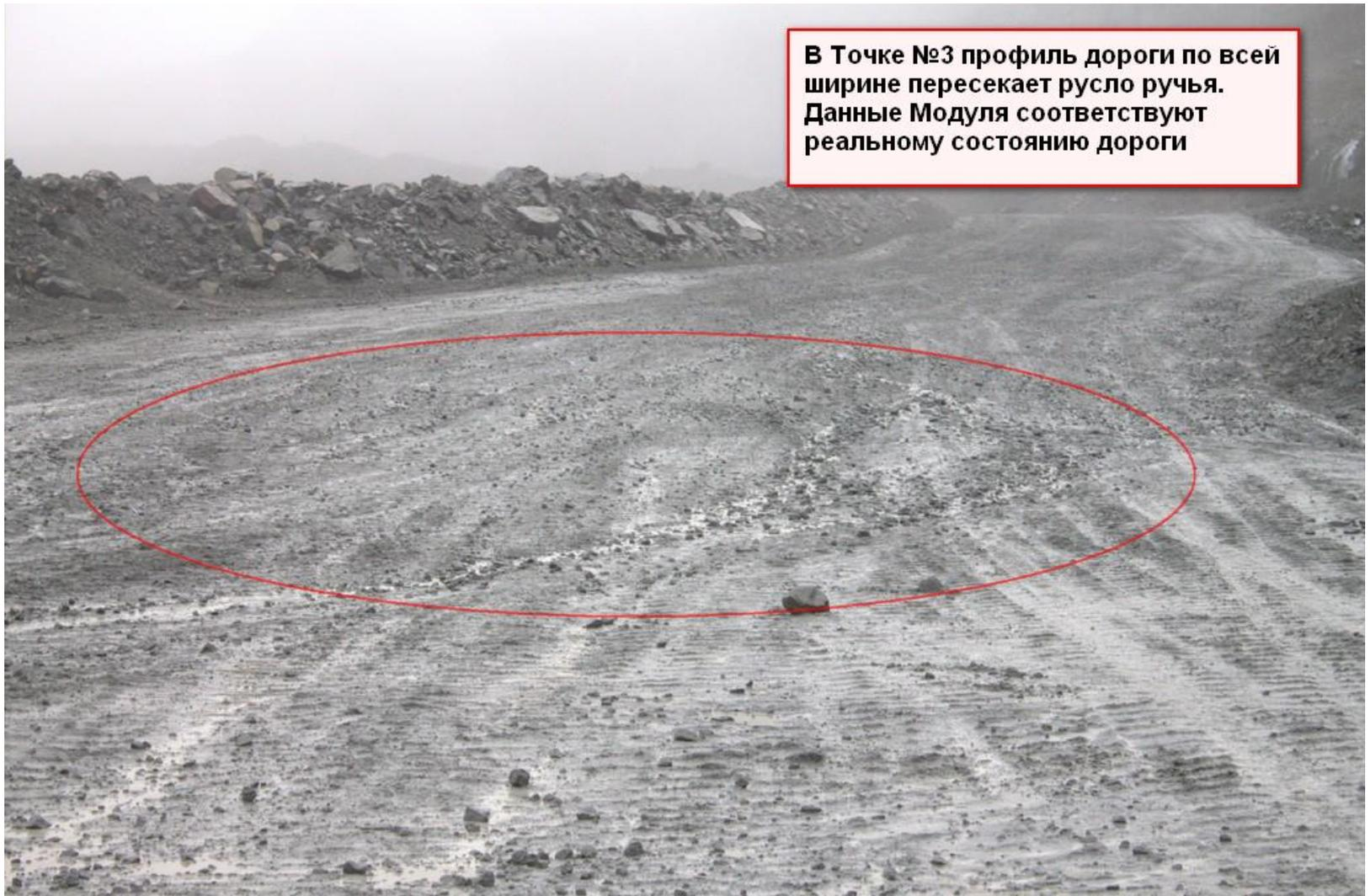
В Точке №3 профиль дороги по всей ширине пересекает русло ручья. Данные Модуля соответствуют реальному состоянию дороги
