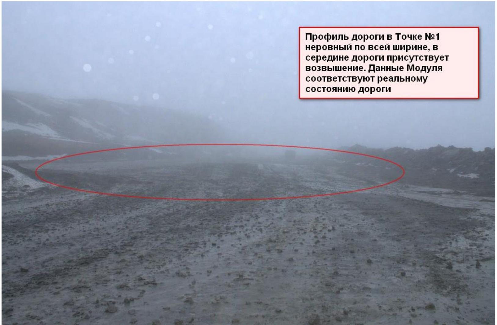
Профиль дороги в Точке №1 неровный по всей ширине, в середине дороги присутствует возвышение. Данные Модуля соответствуют реальному состоянию дороги
