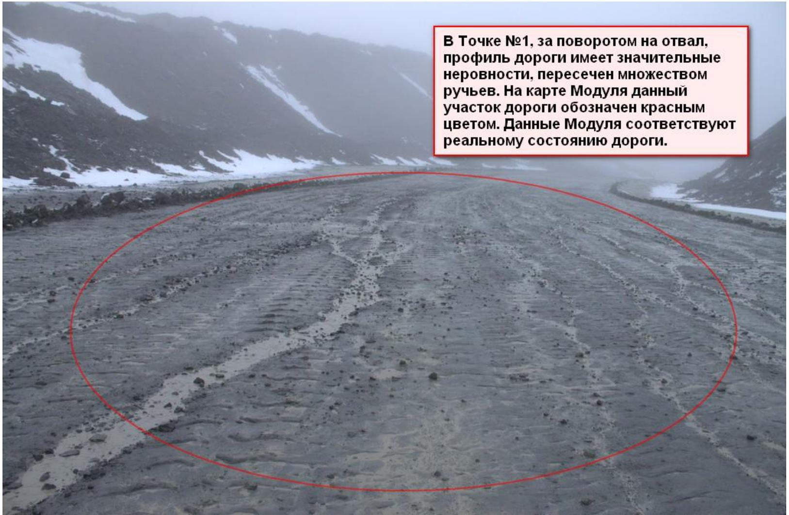
В Точке №1, за поворотом на отвал, профиль дороги имеет значительные неровности, пересечен множеством ручьев. На карте Модуля данный участок дороги обозначен красным цветом. Данные Модуля соответствуют реальному состоянию дороги.
